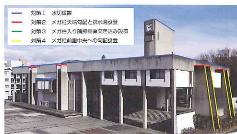
図2 外壁の汚れ防止対策
