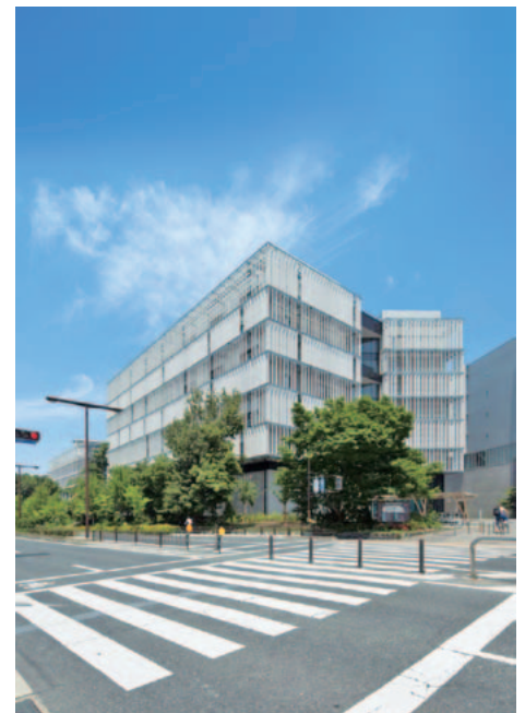
図3 ナショナル・イノベーション・コンプレックスの外観
