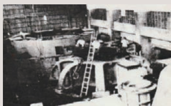
建設中の平岡発電所発電機
