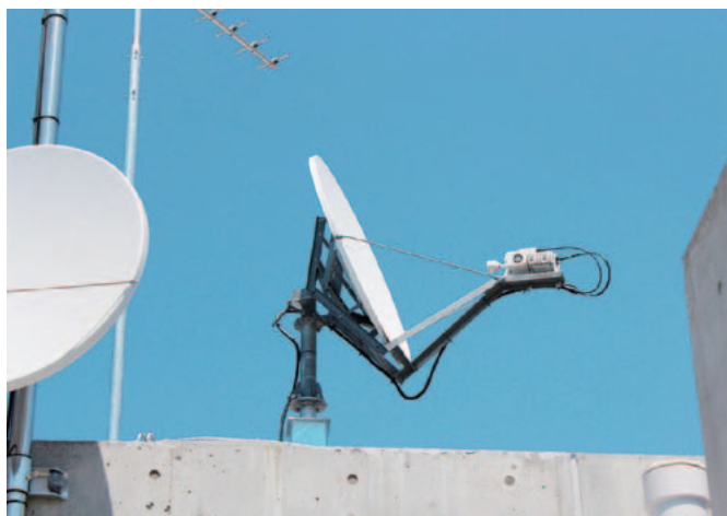
自治体衛星通信用のパラボラアンテナ
