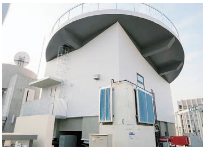
屋上の減災・体感実験室の外観
